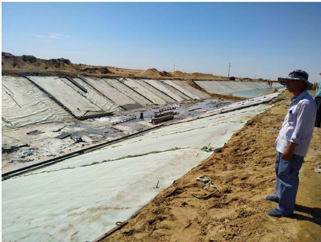
Фото: Бетонирование канала Бустан
