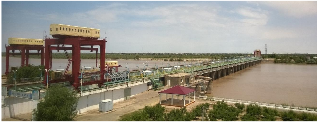
Рисунок 2-3 Тахиташский гидроузел, расположенный ниже по течению от ТМГУ, в Каракалпакстане (УзНКИД, 2020)
