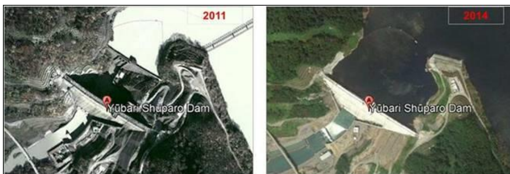
Рисунок 5-17 Сравнение изображений Google Earth до (слева) и после (справа) удаления плотины Оюбари
