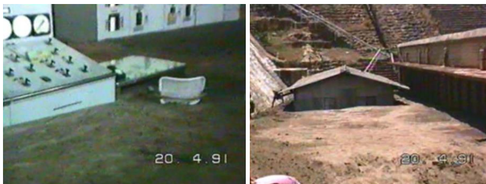
Рисунок 3-20 Затопление илом внутри (слева) и вокруг здания электростанции (справа) в результате аварии, произошедшей при промывании наносов в водохранилище Пилпур в Индии (Гири и др., 2019)
